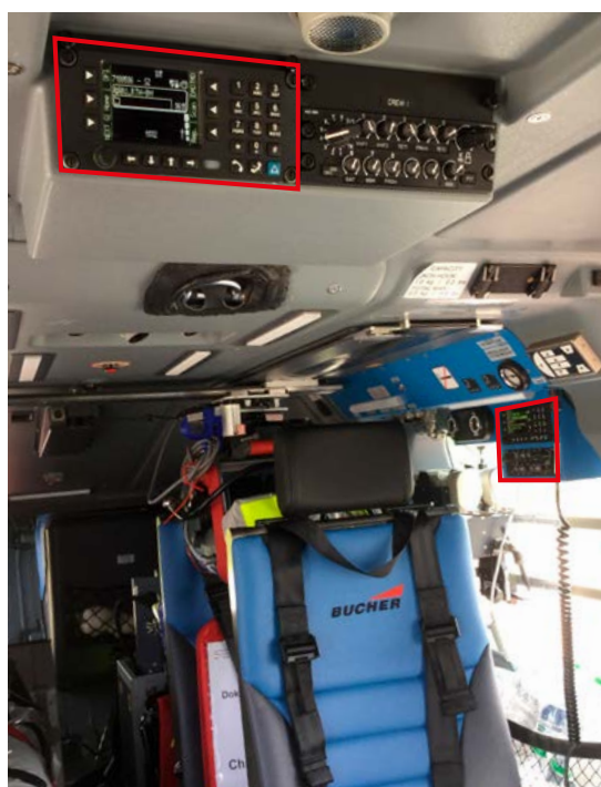
Abb. 2 und 3: Bedieneinheiten für den BOS-Funk und die Aufschaltanlage (Intercom) im Cockpit und in der Kabine
